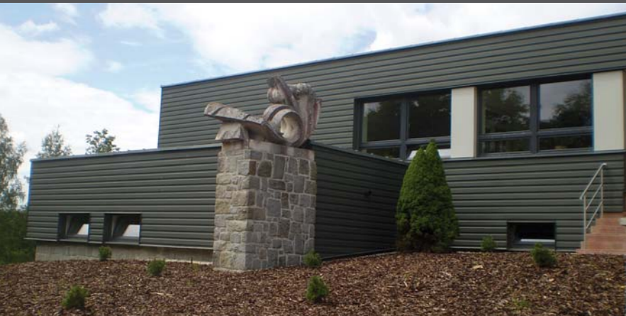
WASSERAUFBEREITUNGSANLAGE, STADT KOUTY NAD DESNOU, CLASSICO, FARBTON TI-ZN VERWITTERTER, SCHIEFERGRAU
