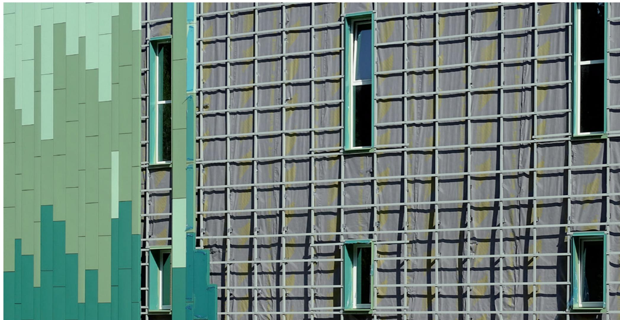
Die Unterkonstruktion ist untrennbarer Bestandteil des DEKMETAL-Fassadensystems.
